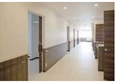
連続手摺の廊下
