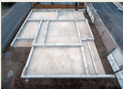
【基礎工事】コンクリートパネルを設置する 強固な土台、基礎の完成です。
