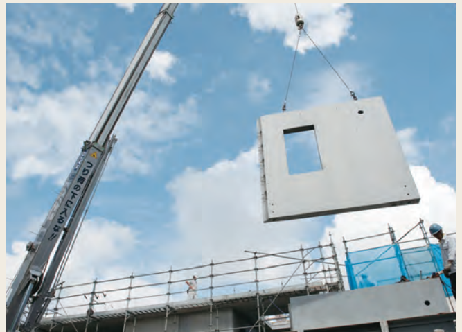
大型クレーンを用いて1枚1枚正確に設置します。
