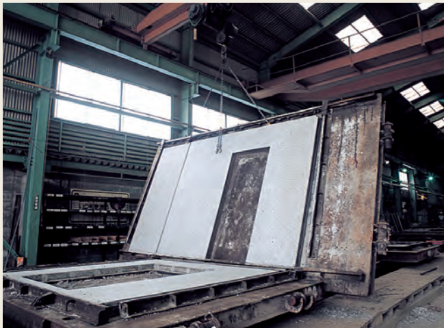
促進養生を終えたコンクリートパネルを型枠から取り外します。
