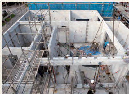
【建て方】工場生産のコンクリートパネルを パネル配置図に従って設置します。
