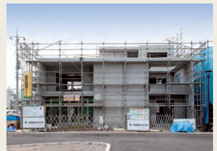
【躯体完成】コンクリートパネルを設置した後 パネル接合部を仕上げて上棟です。
