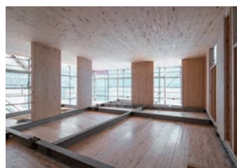
FMT構法の施工現場 (三菱地所ホームモデルハウス)
