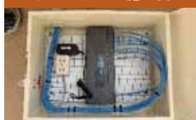
イーブロードの施工例
