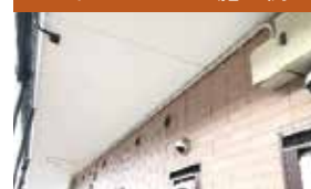
イーブロードの施工例
