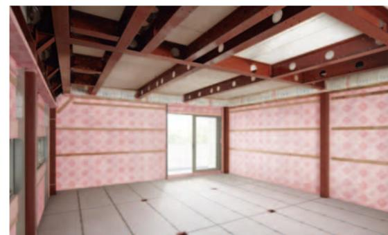
ALCコンクリート・ヘーベルと高性能断熱材ネオマフォームを組み合わせた二重構造で、高い断熱性能を実現。夏の暑さや冬の寒さを遮り、結露の発生を防ぎます。快適な居住環境を長期間持続し、高い入居率を維持することができます。
